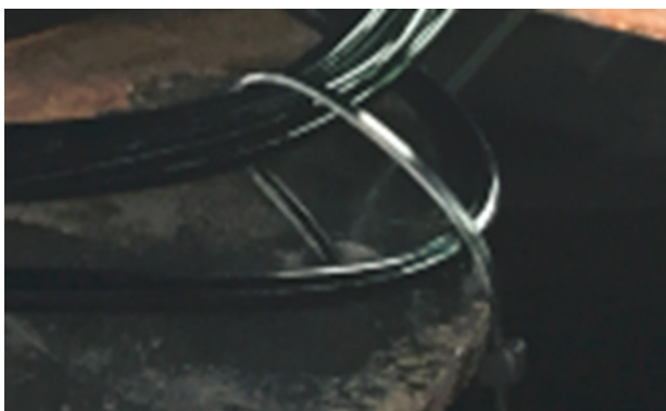
Abb.: 11 - Leitungen am Rahmen befestigen
