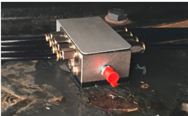
Abb.: 15 - Installation abgeschlossen
